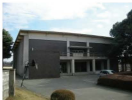
当社施工 熊本電波高専体育館 (改修)
